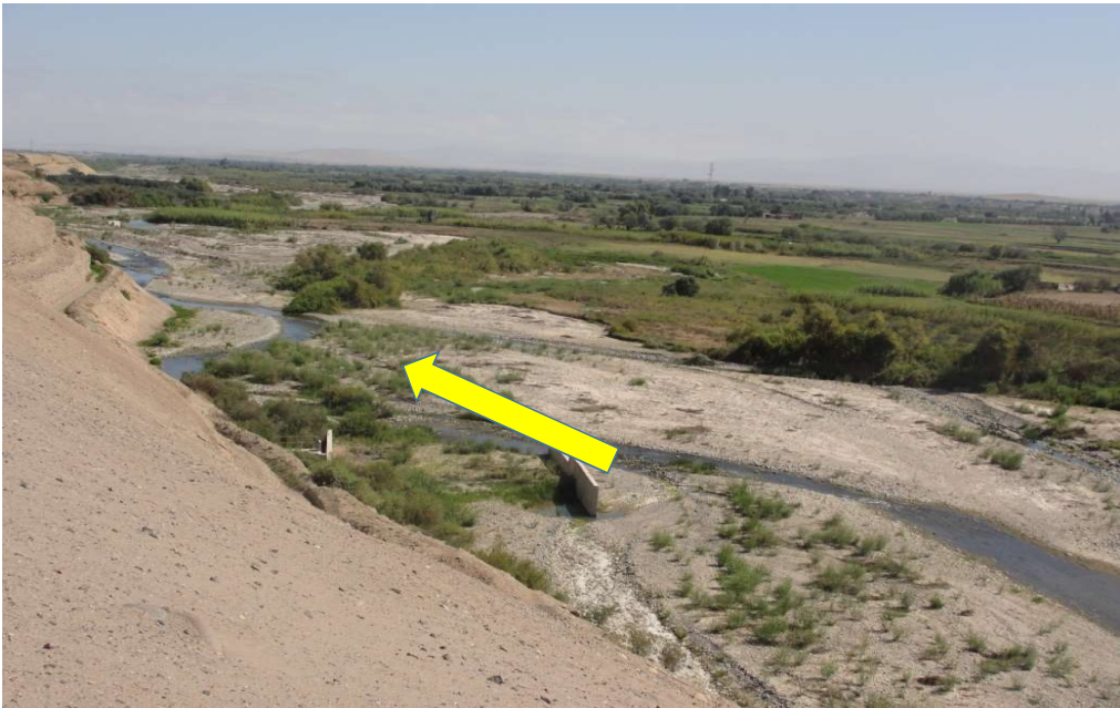
FIGURA N°03: EN LA TEMPORADA DE MAXIMAS AVENIDAS EL RÍO SAMA, SE DESBORDA, POR LA MARGEN DECHECHA, EN EL SECTOR MARANGO, DISTRITO DE SAMA - TACNA, CUYO TRAMO SE ENCUENTRA COLMATADO Y DESPROTEGIDO, VULNERABLE A LAS
